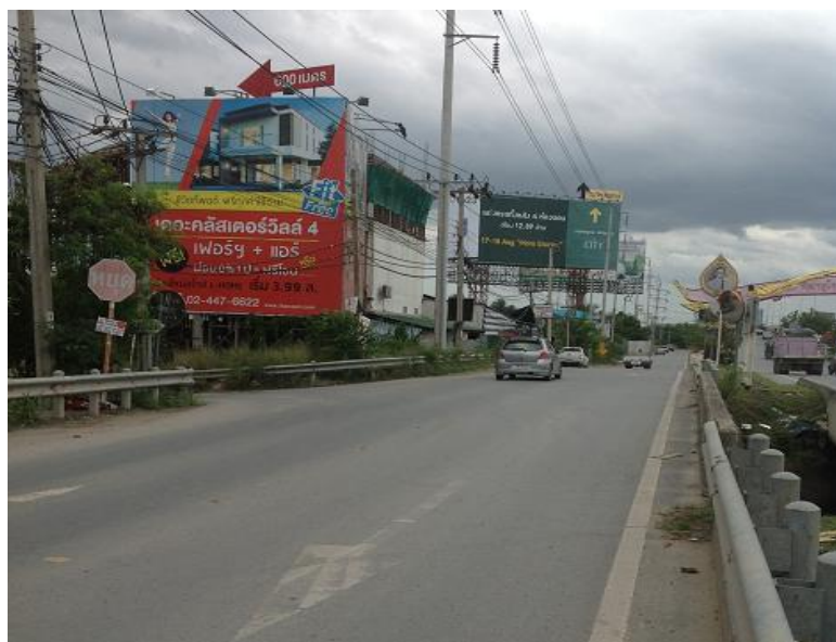
รูปที่ 2.81 ทางเข้าถนนบางกรวย-จตุรนต์ จากถนนราชพฤกษ์ ที่มา: บันทึกภาพถ่ายเมื่อ 16 สิงหาคม 2556
